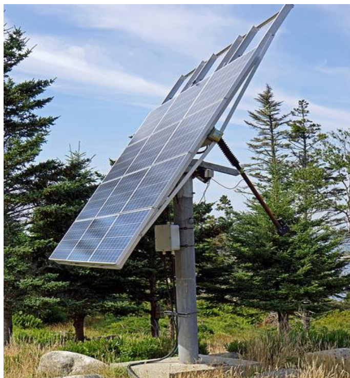
Rys. Solar tracker - budowa (źródło zdjęcia flickr.com, autor Dennis Jarvis)
