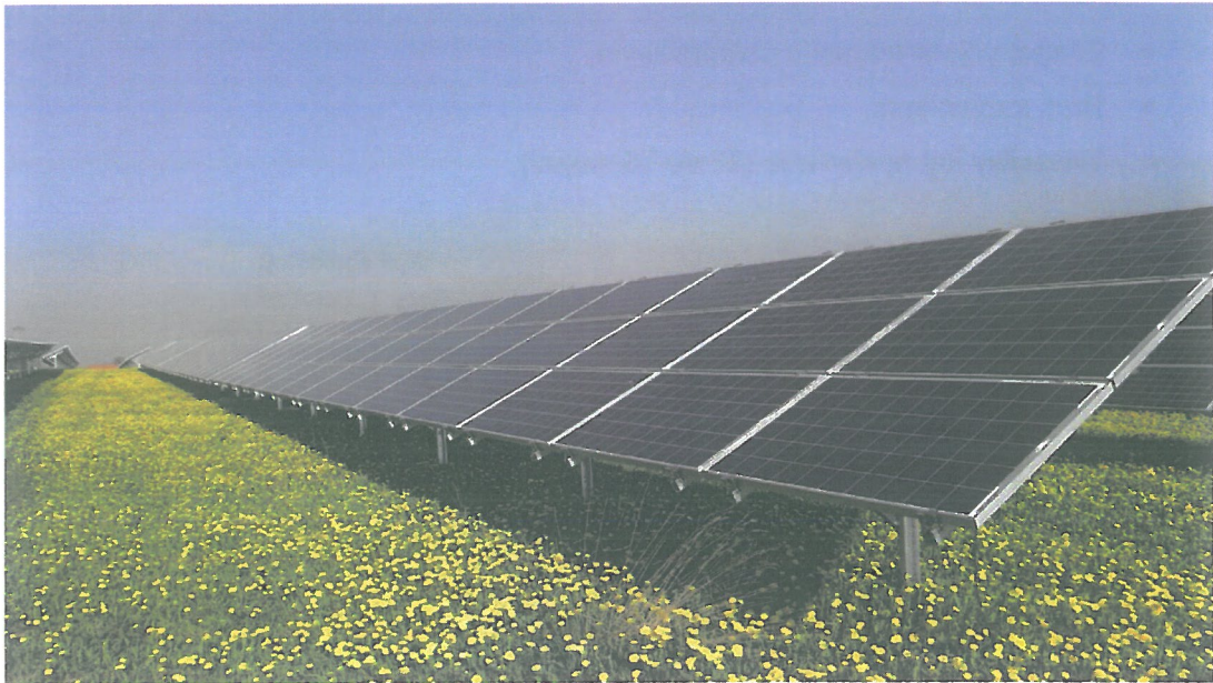
Rysunek 7: Sposób montażu paneli fotowoltaicznych na stelażach wbijanych bezpośrednio do gruntu (źródło: Farma fotowoltaiczna Netmannsdors – Niemcy, http://www.projekt-solarteknik.pl/ ).
