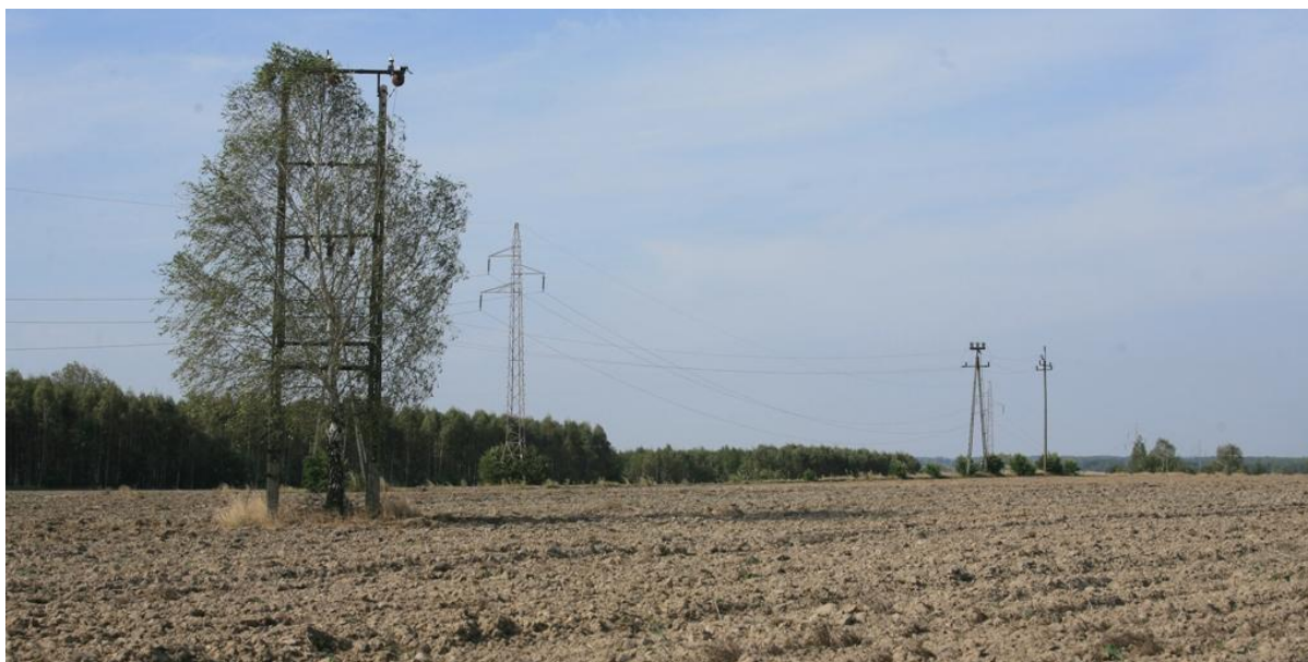
Fot. 4. Linie energetyczne przecinające zachodnią część działki i tereny sąsiednie
